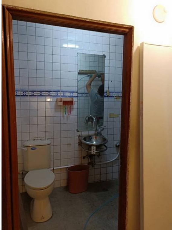
北屯修繕案浴廁完成加裝扶手等改善措施
