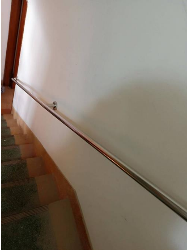
北屯修繕案完成安裝梯間不鏽鋼安全扶手
