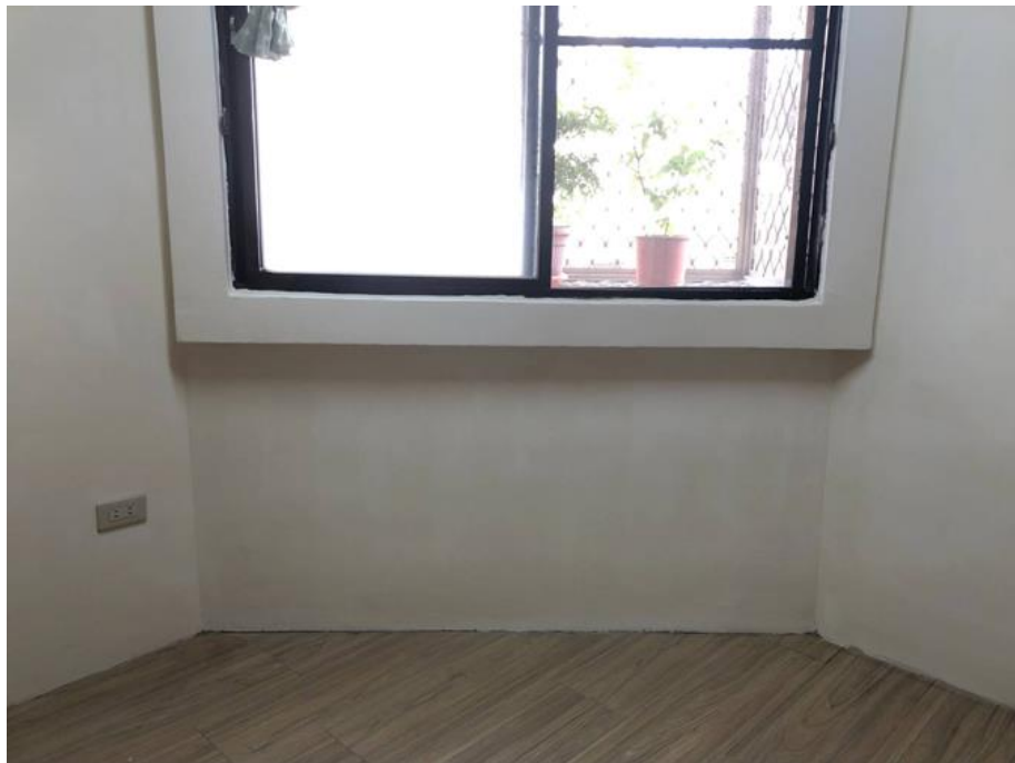
南區修繕案牆面改善完成
