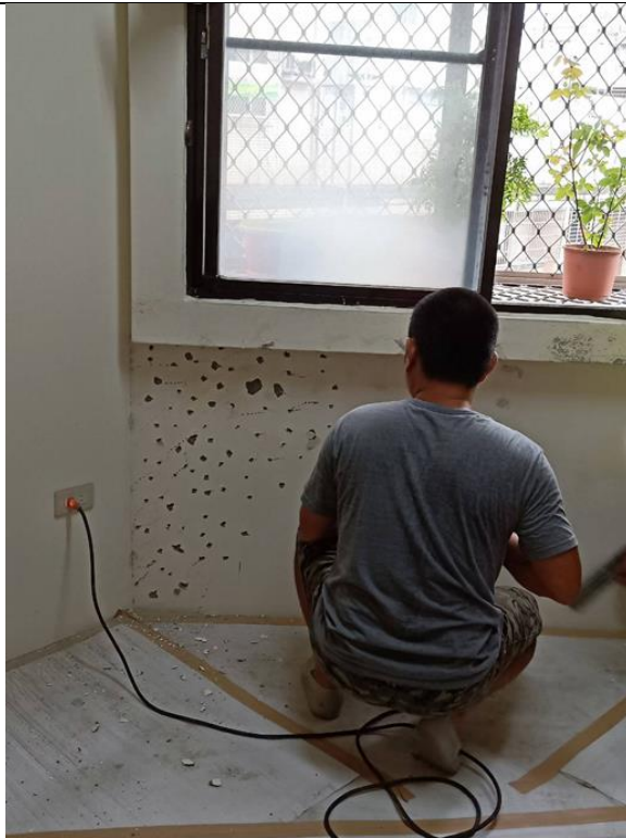
南區修繕案志工隊進行漏水改善工程
