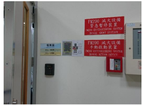
↑偵煙式 FM200 氣體滅火設備
