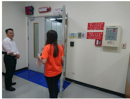
↑偵煙式 FM200 氣體滅火設備
