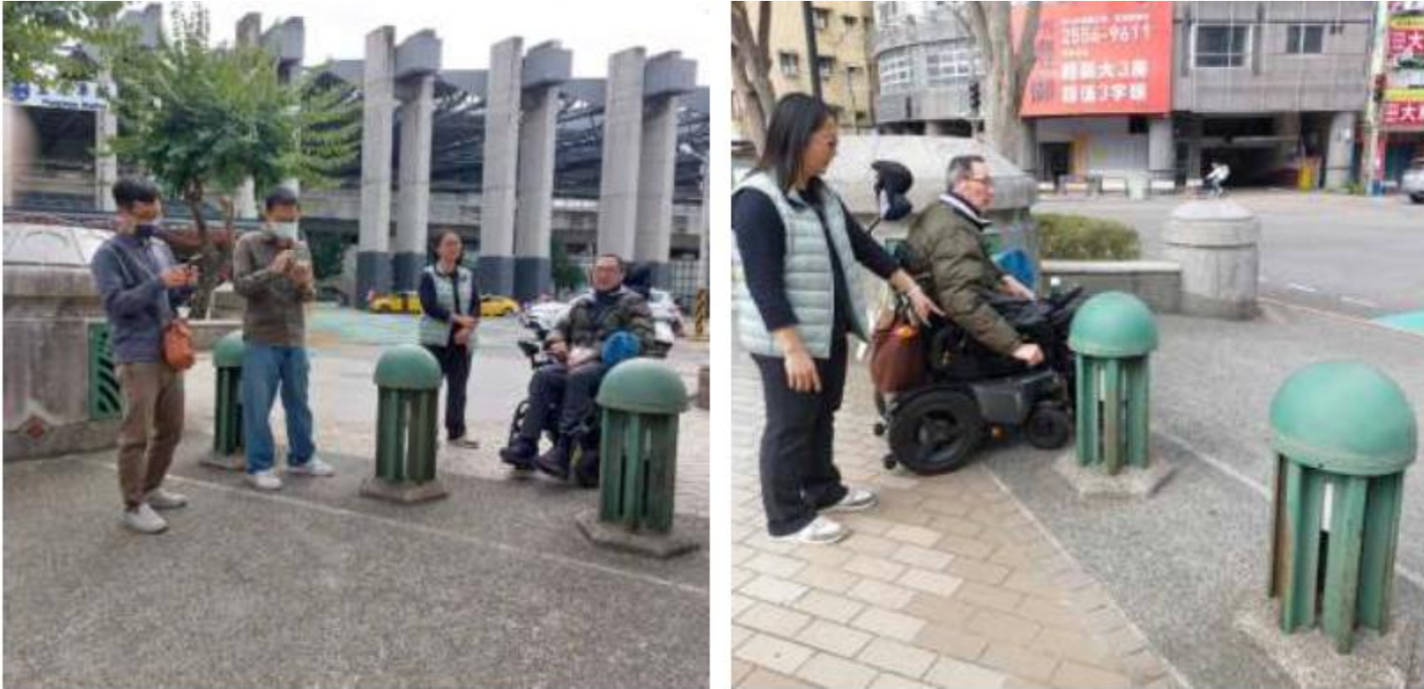
阻車欄杆間隙太小，使用輪椅通行困難
