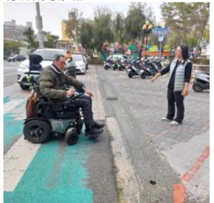
廣場內排水溝蓋設計有凹陷
