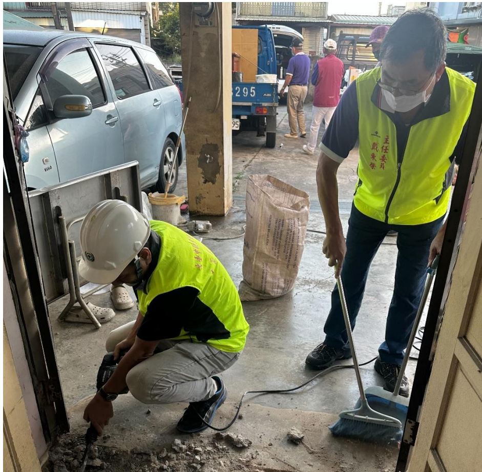
清水區案施工中:工會修繕志工團隊進行門檻改善工程。
