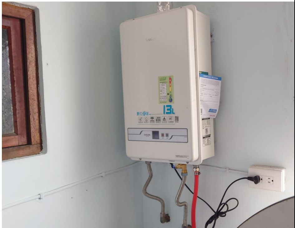
清水區案施工完成:完工照。
