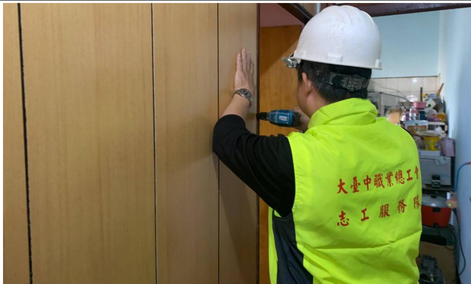
清水區案施工中:工會修繕志工團隊進行室內隔間汰換工程。
