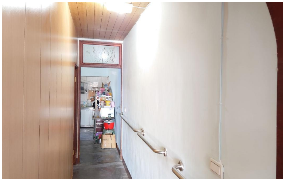
清水區案施工完成:申請人住家房間走廊隔間完工照。
