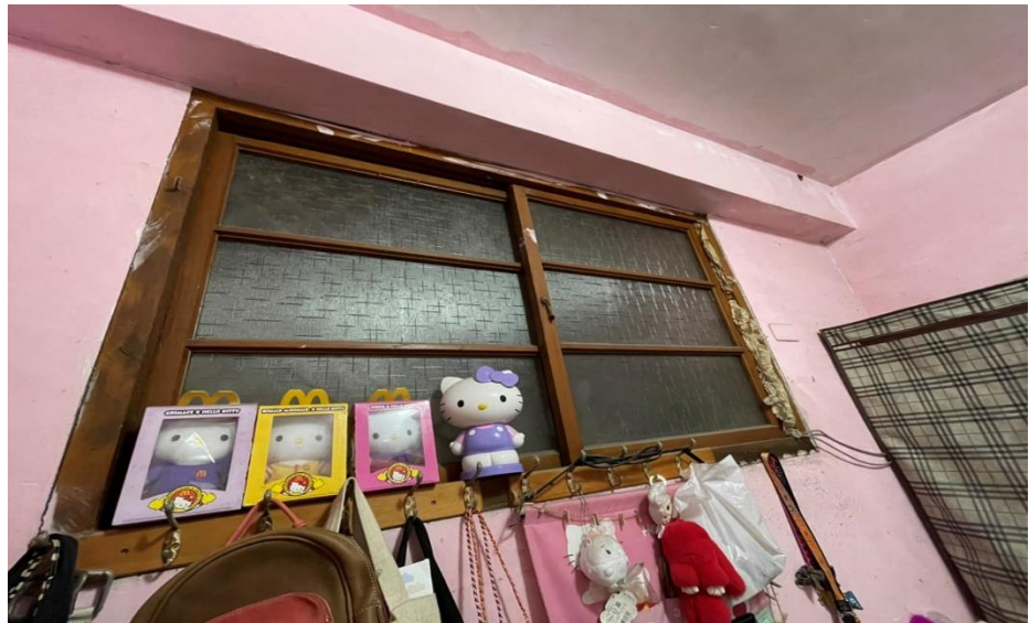
施工前:木框窗年久失修，每逢遇強風豪雨會產生巨大聲響或滲水
