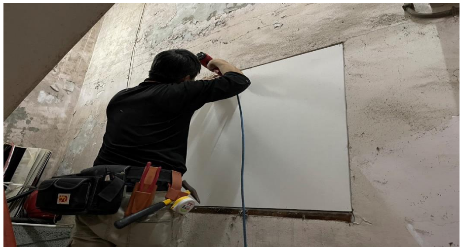
施工中:師傅由窗外進行施工作業
