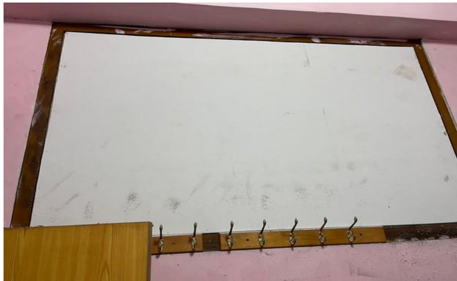
施工後:矽酸鈣板修繕完成
