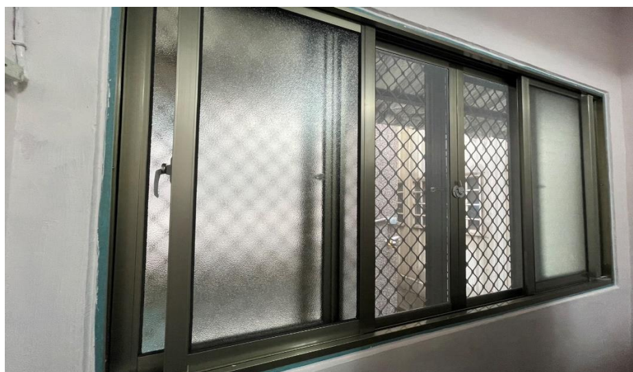
施工後:鋁窗防盜窗修繕完工
