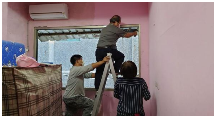
施工中:鋁窗防盜窗修繕中
